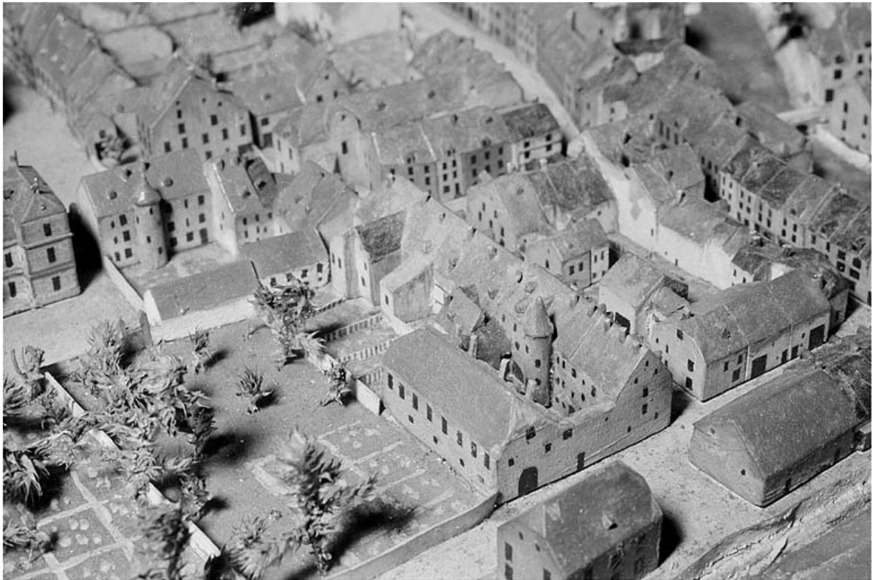
Vue d'ensemble de l'ancienne ferme, 1823-1826. Extrait du plan-relief de 1823-1826, par R.G.I. Wild, échelle 1:1000 (conservé au Musée historique du Vieux Montbéliard).
