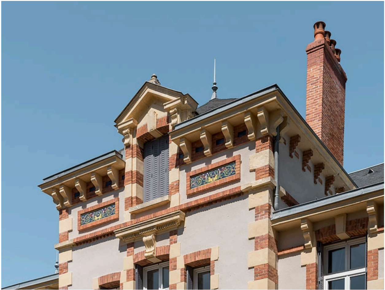
Avant-corps central de la façade principale, détail.
