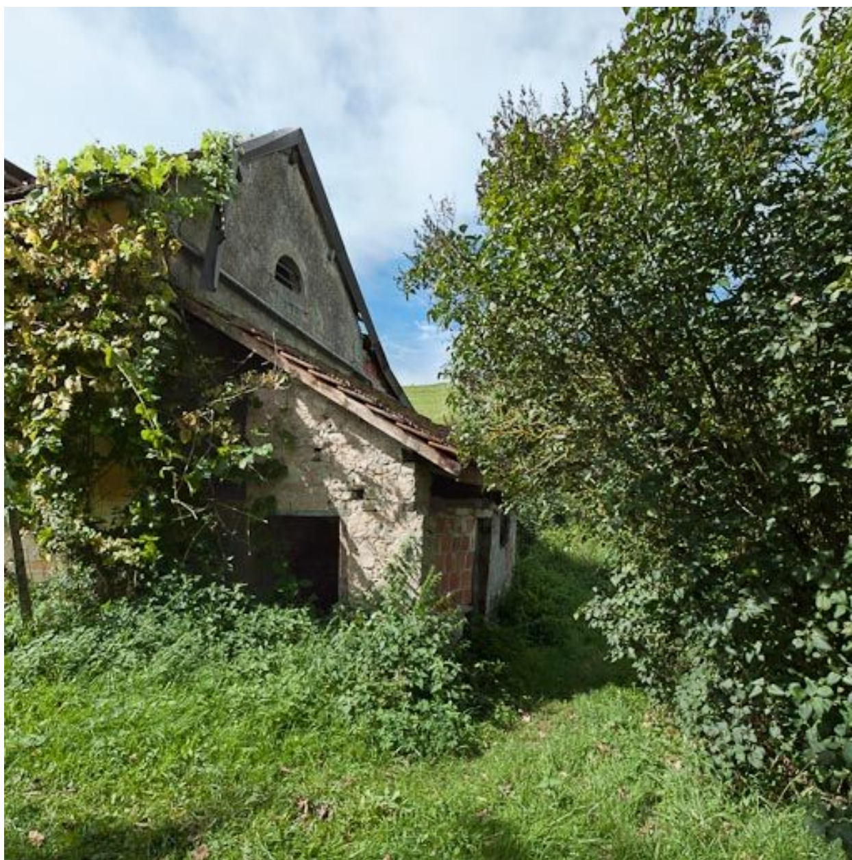
Vue de l'annexe latérale.
