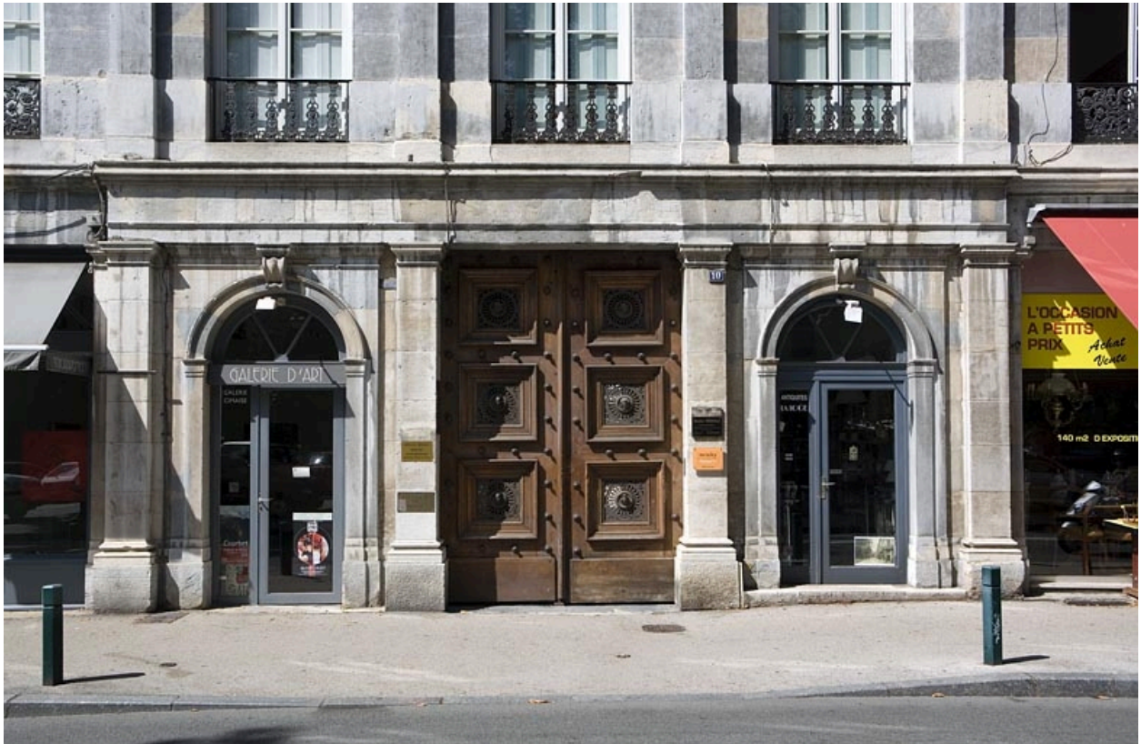
Façade sur rue : détail du portail d'entrée.
