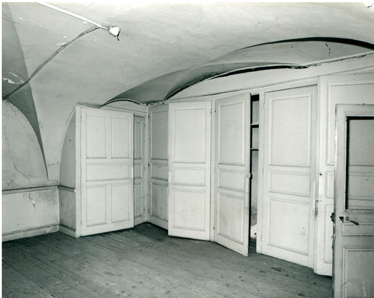
Rez-de-chaussée du bâtiment conventuel. Pièce côté sud, 1997.
