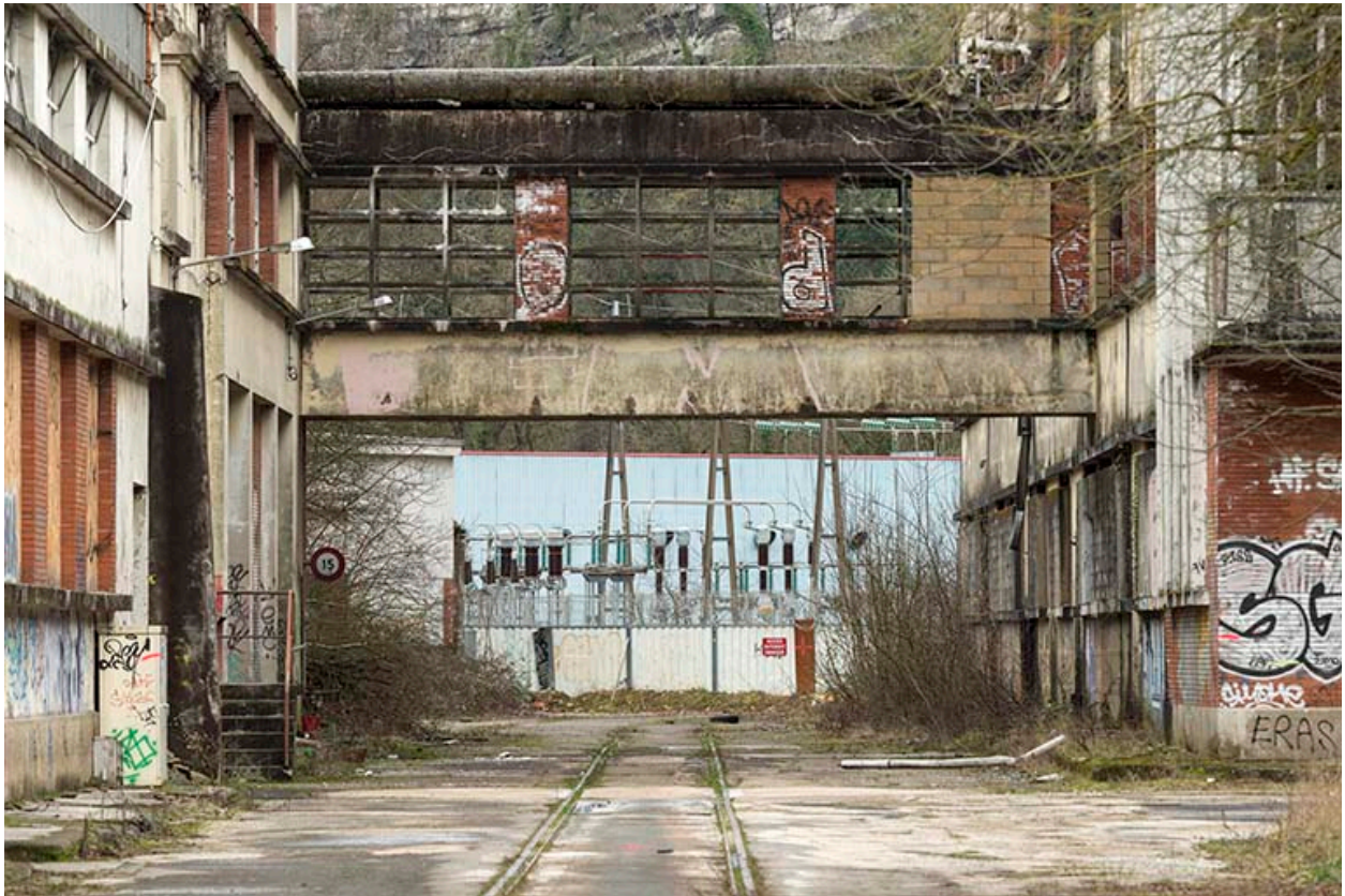
Etat en 2016. Usine A : passerelle entre la chaufferie (P) et les filatures tergal et nylon (V).
