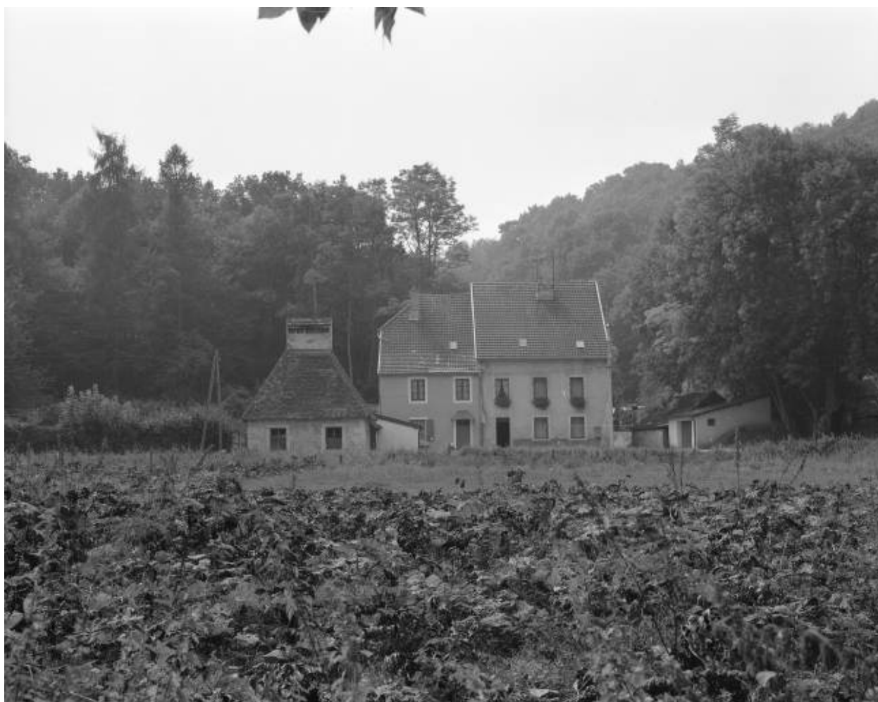
Séchoir-buanderie, logement et bureau en 1981.
