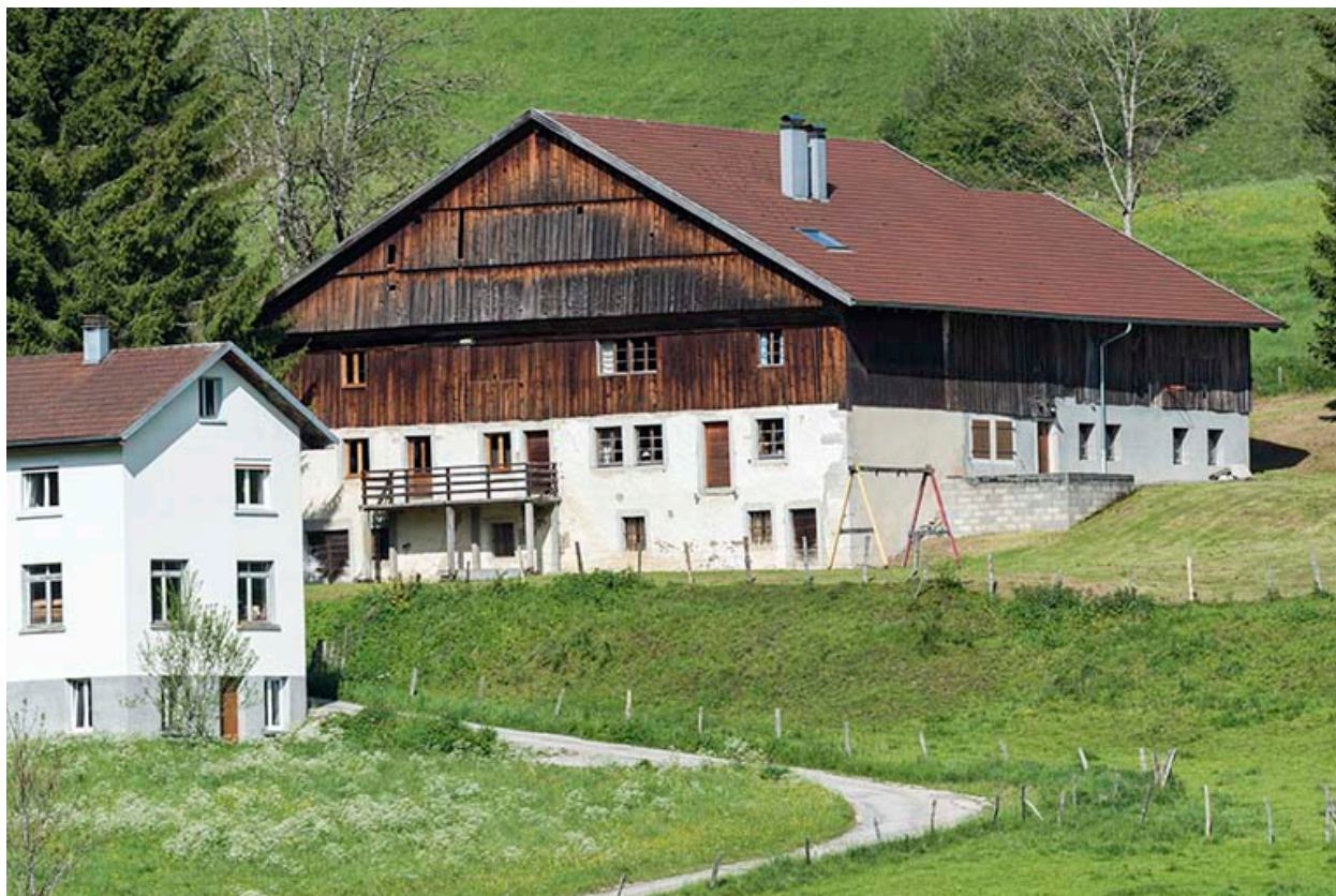
Façades antérieure et latérale droite.
