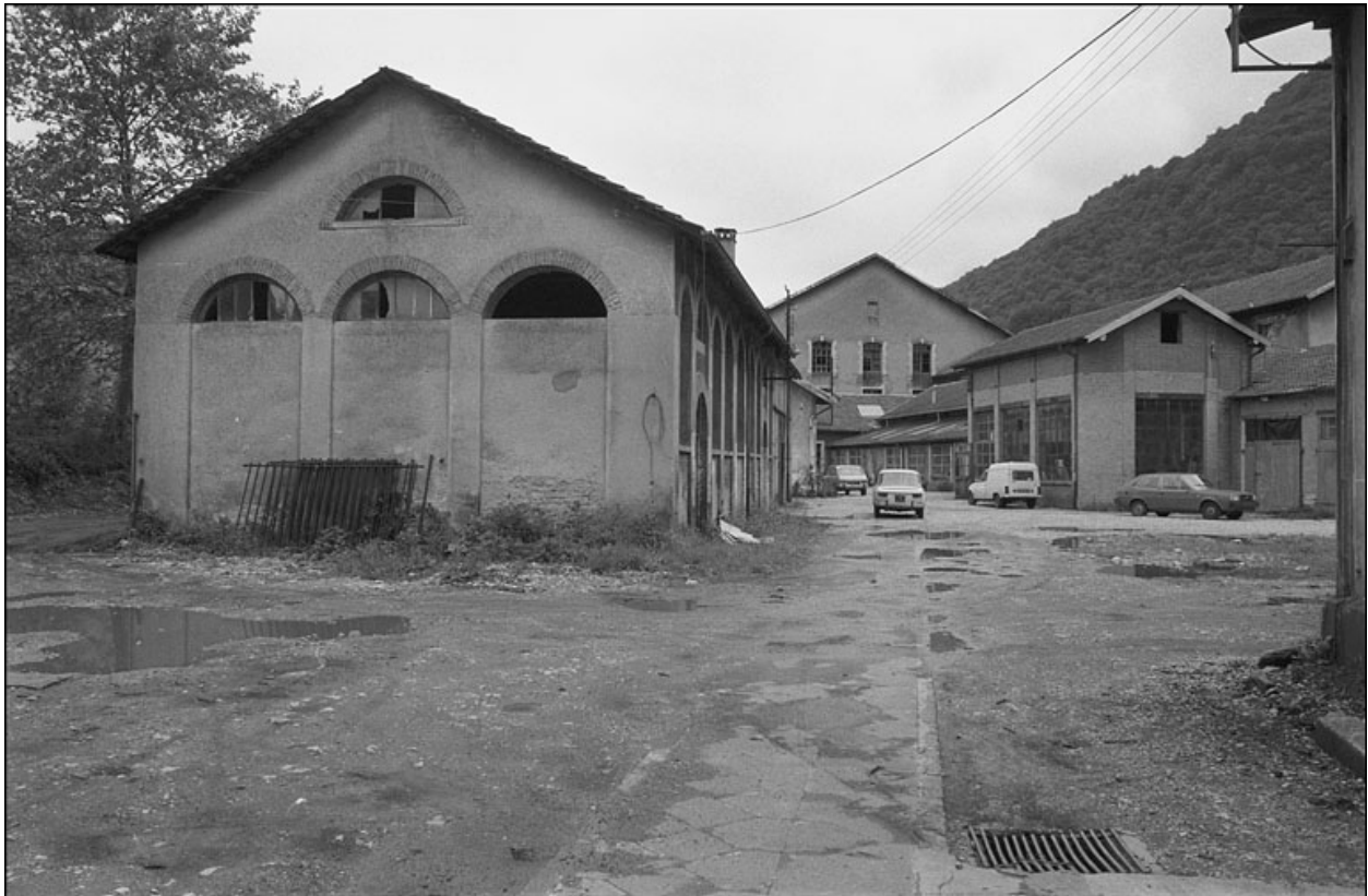
Vue des ateliers de réparation sud en 1980.
