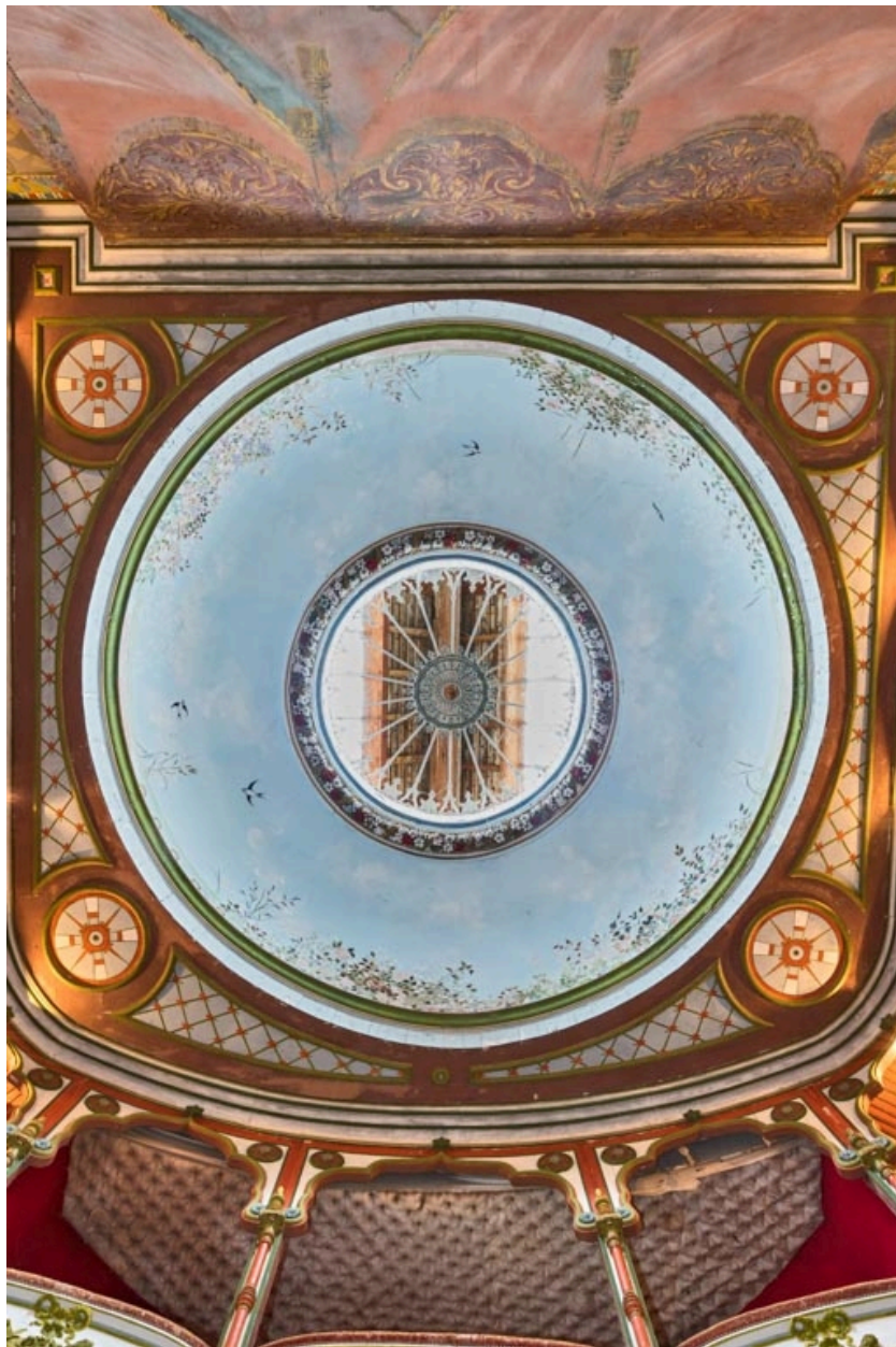
Salle : vue d'ensemble du plafond (fausse coupole).
