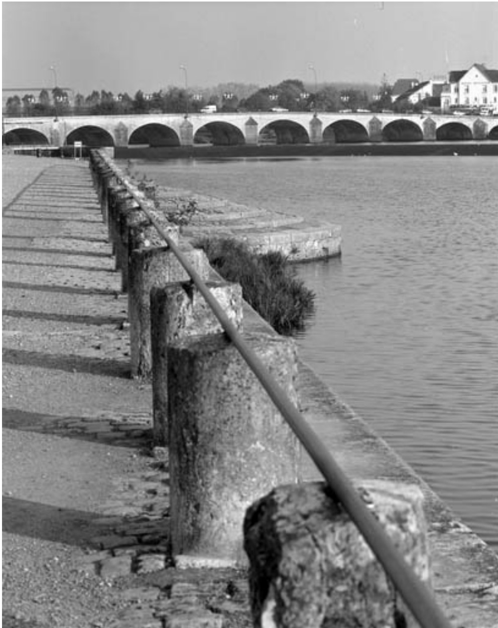
Vue d'ensemble depuis le quai de l'Ecluse.
