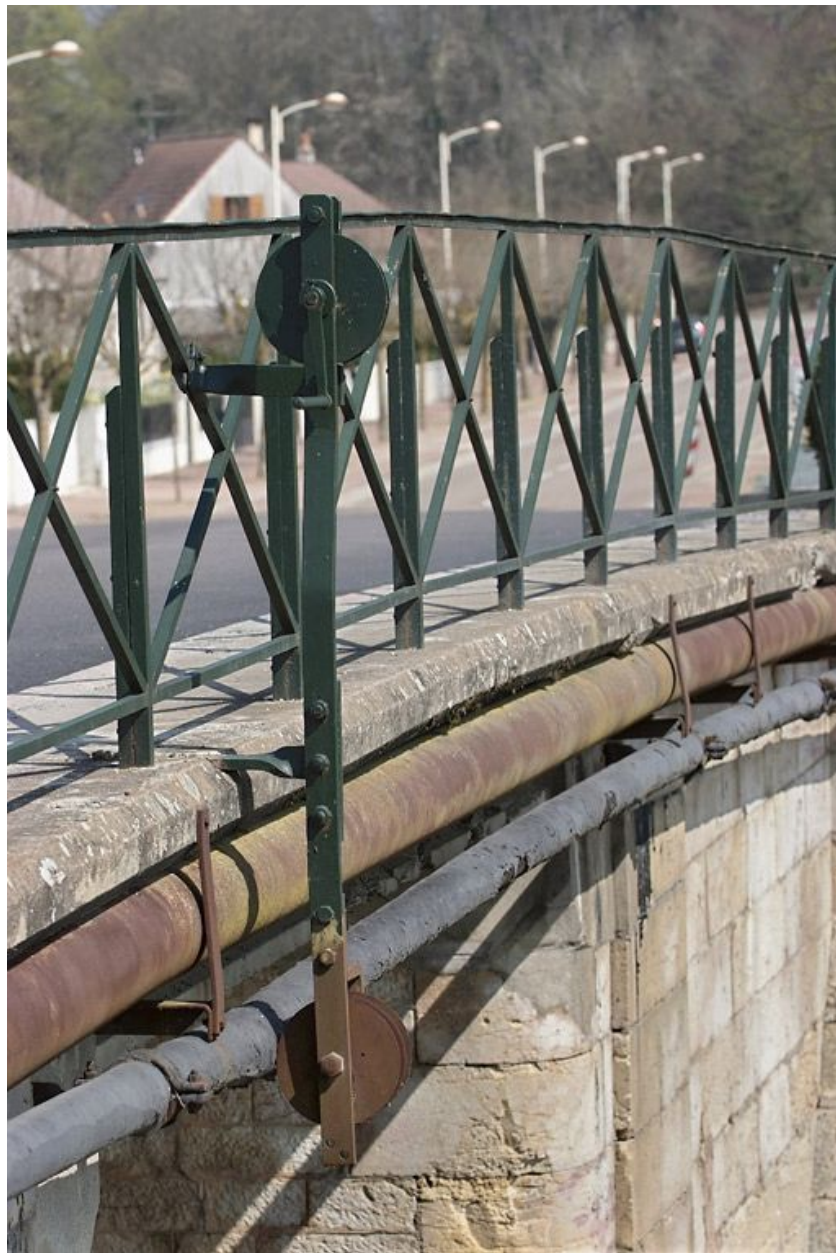
Poulie installée en aval du pont.
