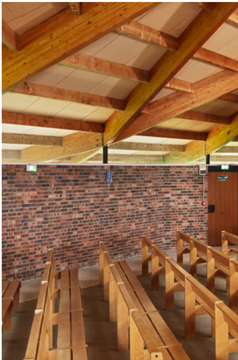
Charpente et entrée nord-est. Vue d'ensemble.
