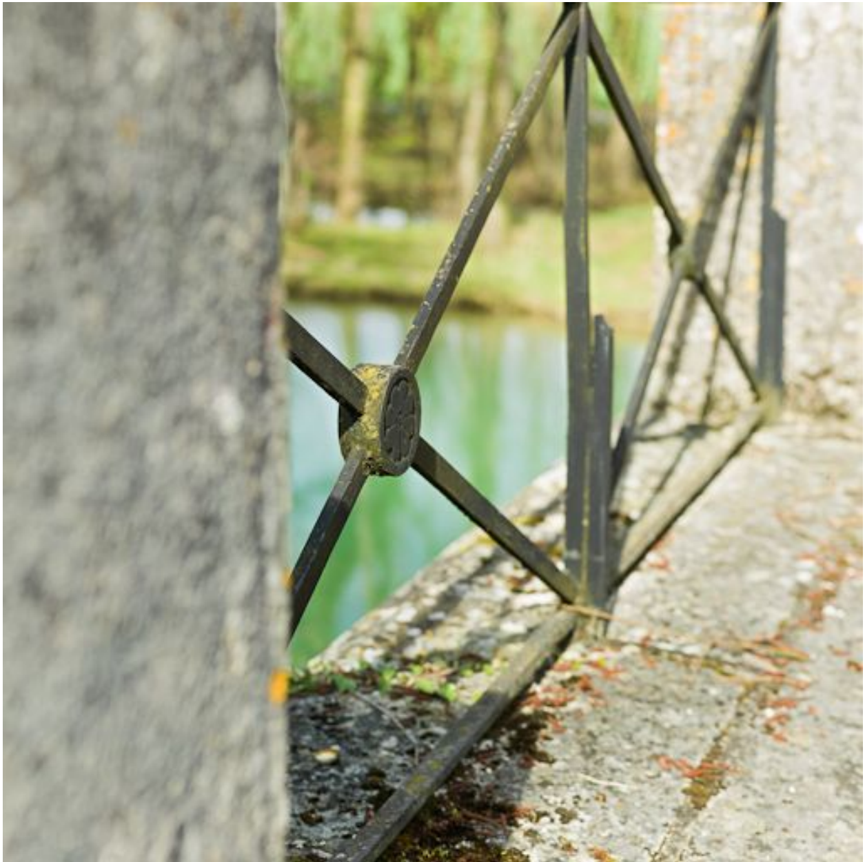
Détail du garde-corps.
