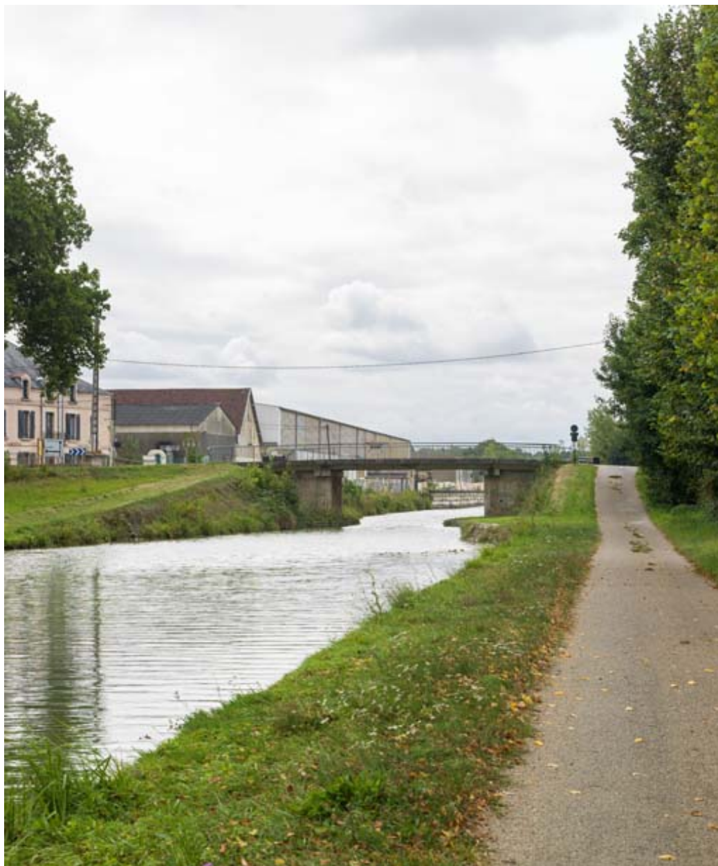
Vue d'ensemble du pont.
