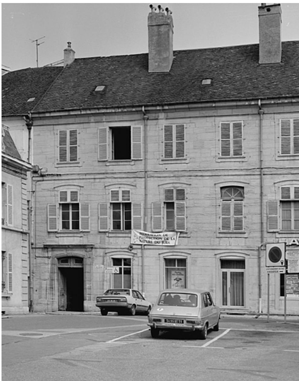
Façade antérieure, partie gauche.
