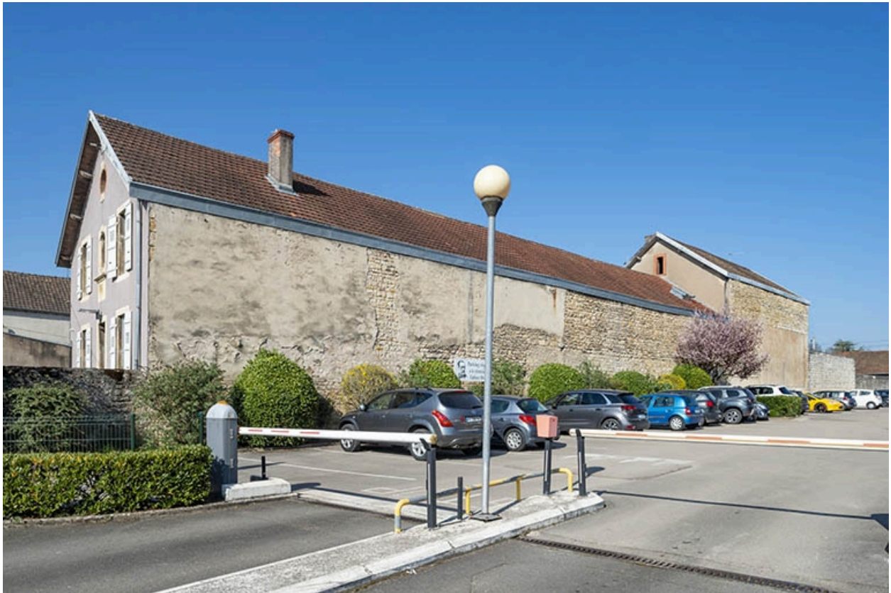
Façade latérale droite.
