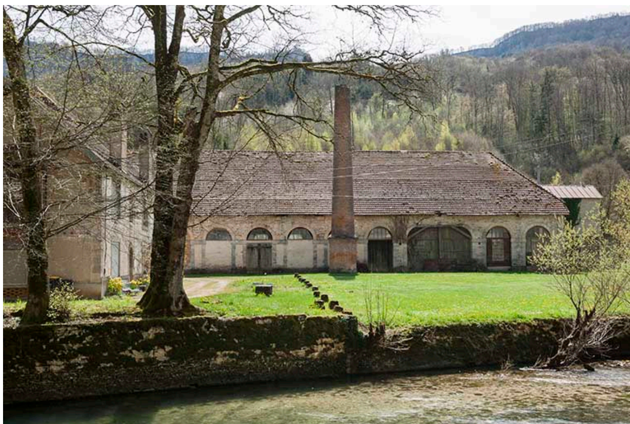
Façade nord de l'atelier de fabrication.
