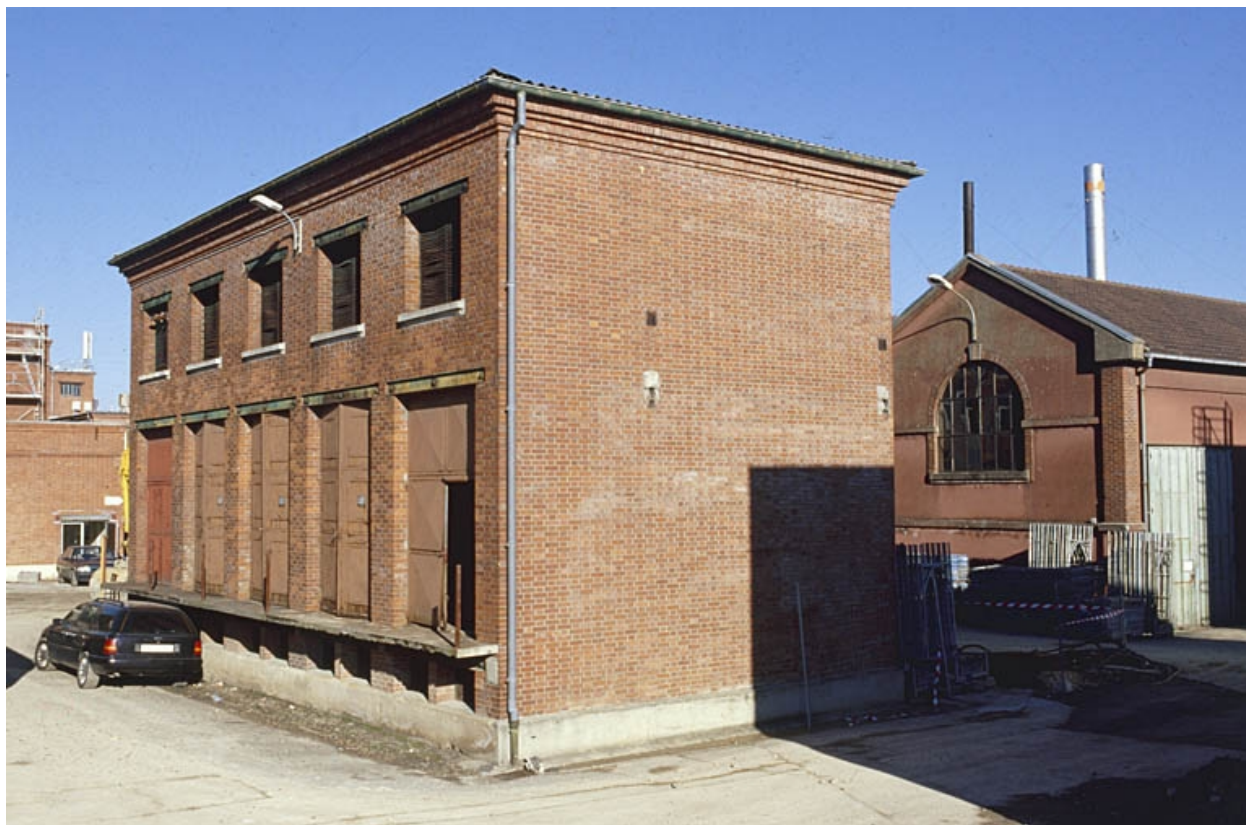
Transformateur : vue depuis le sud-ouest.
