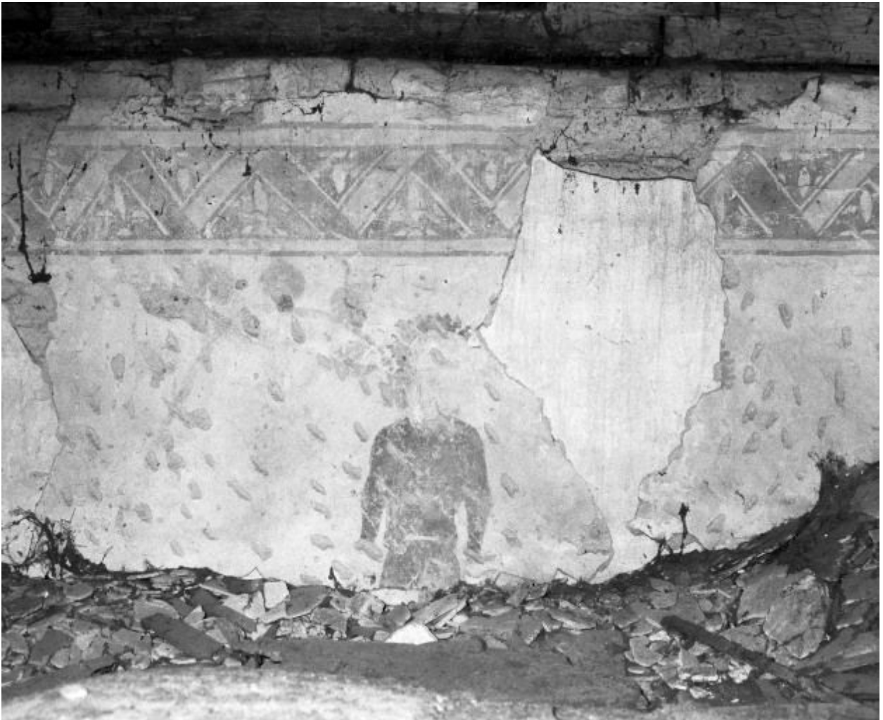
Comble de la nef, mur gauche, 3e-4e travées
