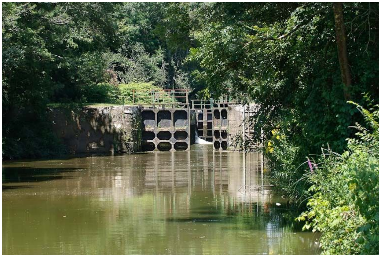
Le sas de l'écluse, vu d'aval.
