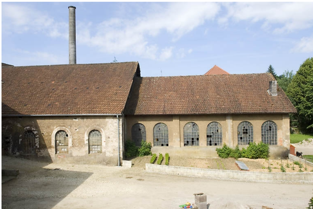
Façade est de l'atelier de fonderie.
