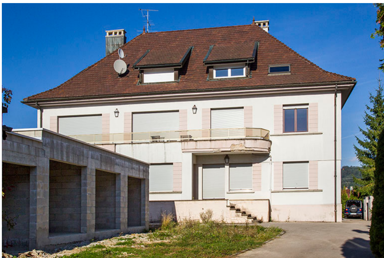
Maison : façade côté usine.
