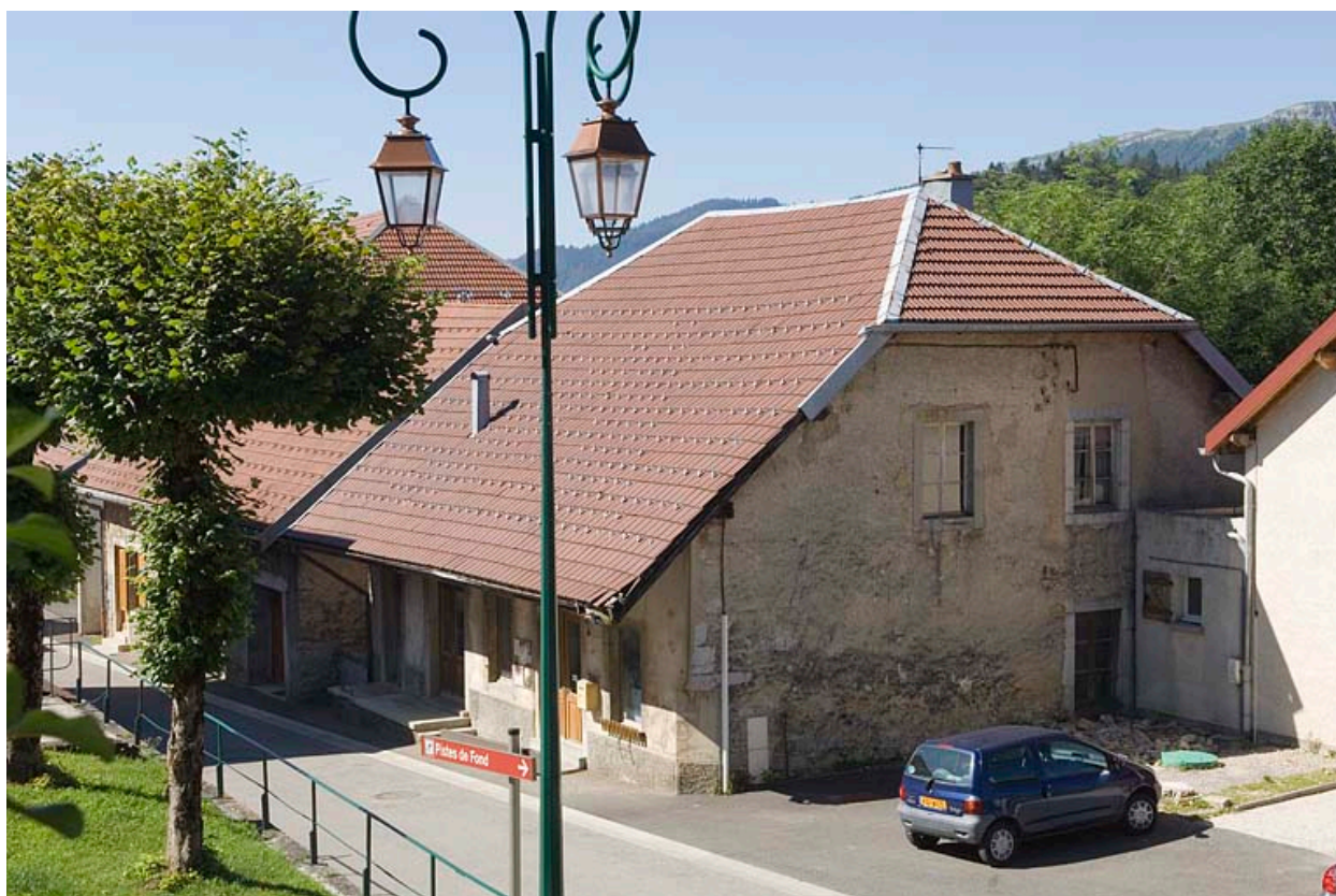
Façade antérieure et façade latérale droite.
