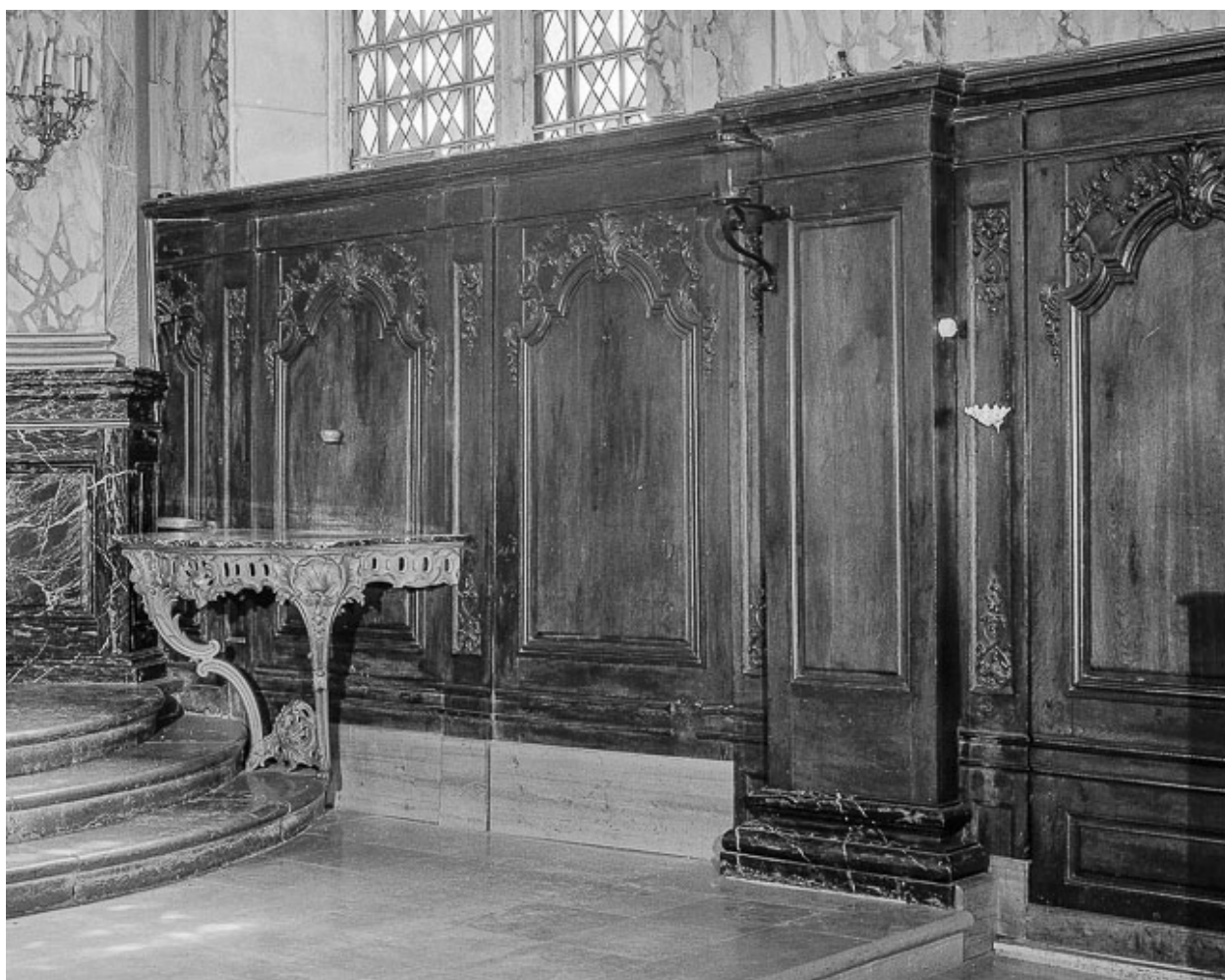
Détail : lambris, mur droit et crédence.
