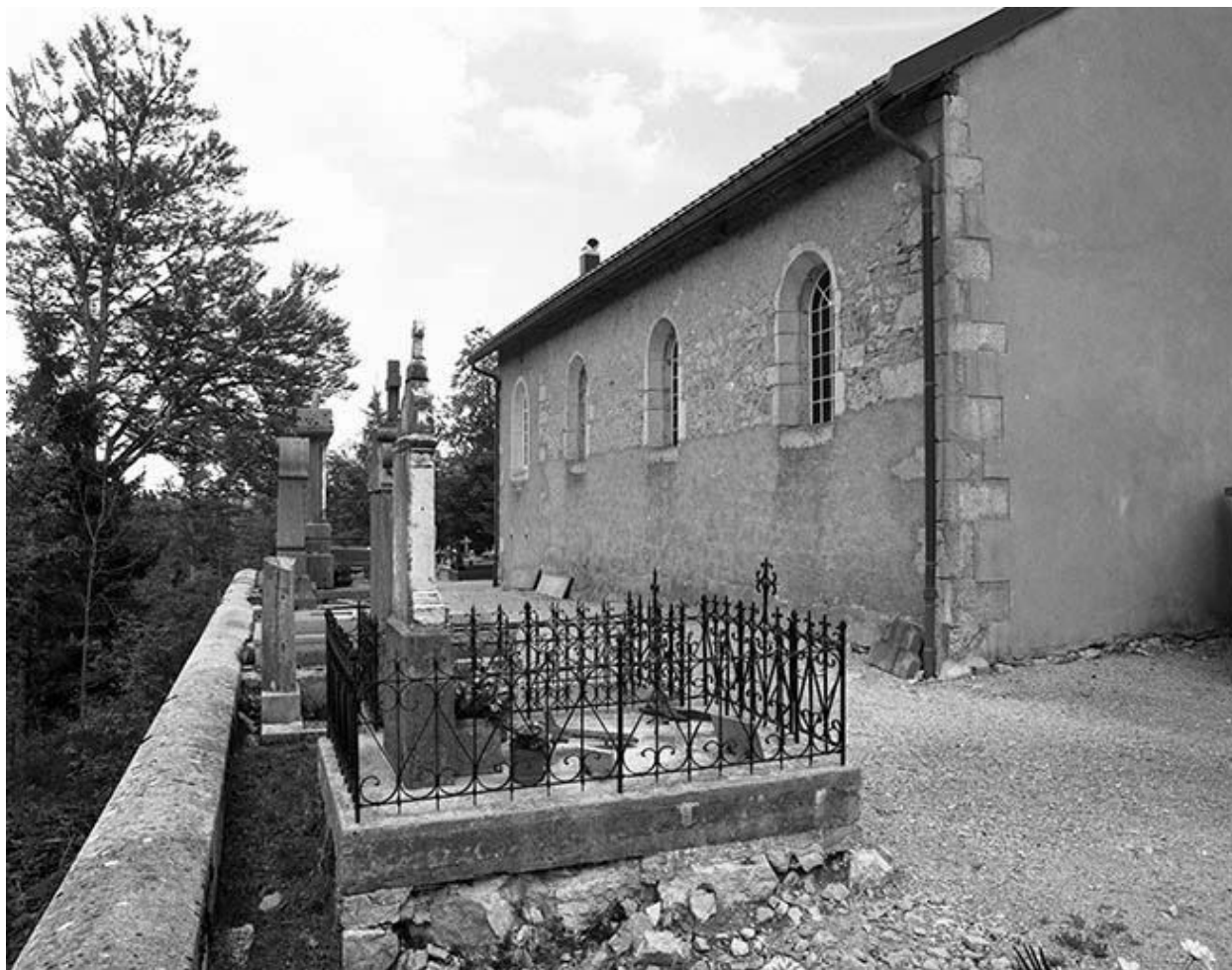
Façade gauche vue de trois quarts.
