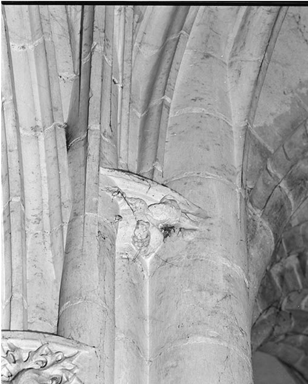
Collatéral droit, 3e travée, pilier postérieur gauche : détail du culot supérieur.
