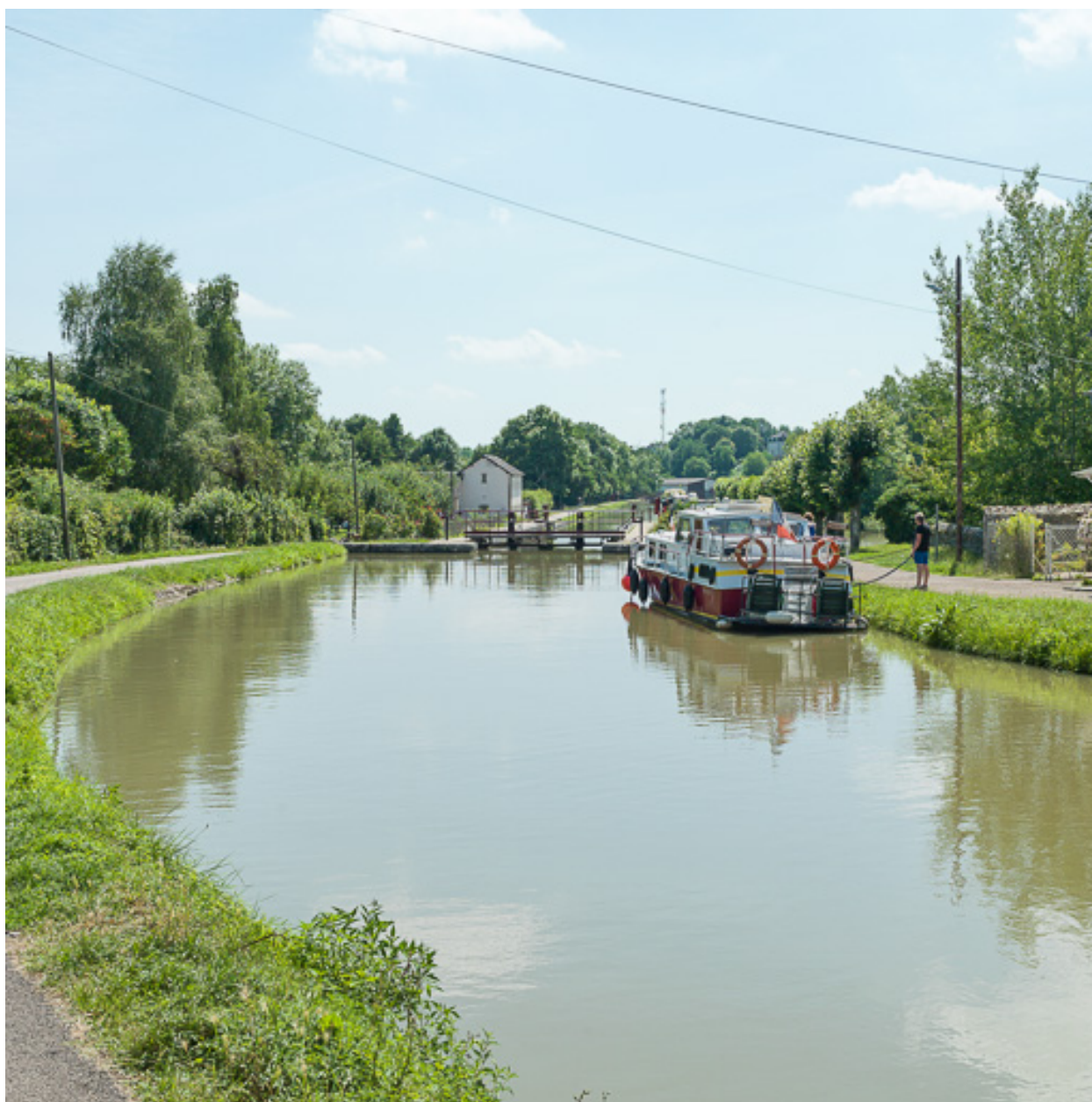
Vue du site d'écluse.
