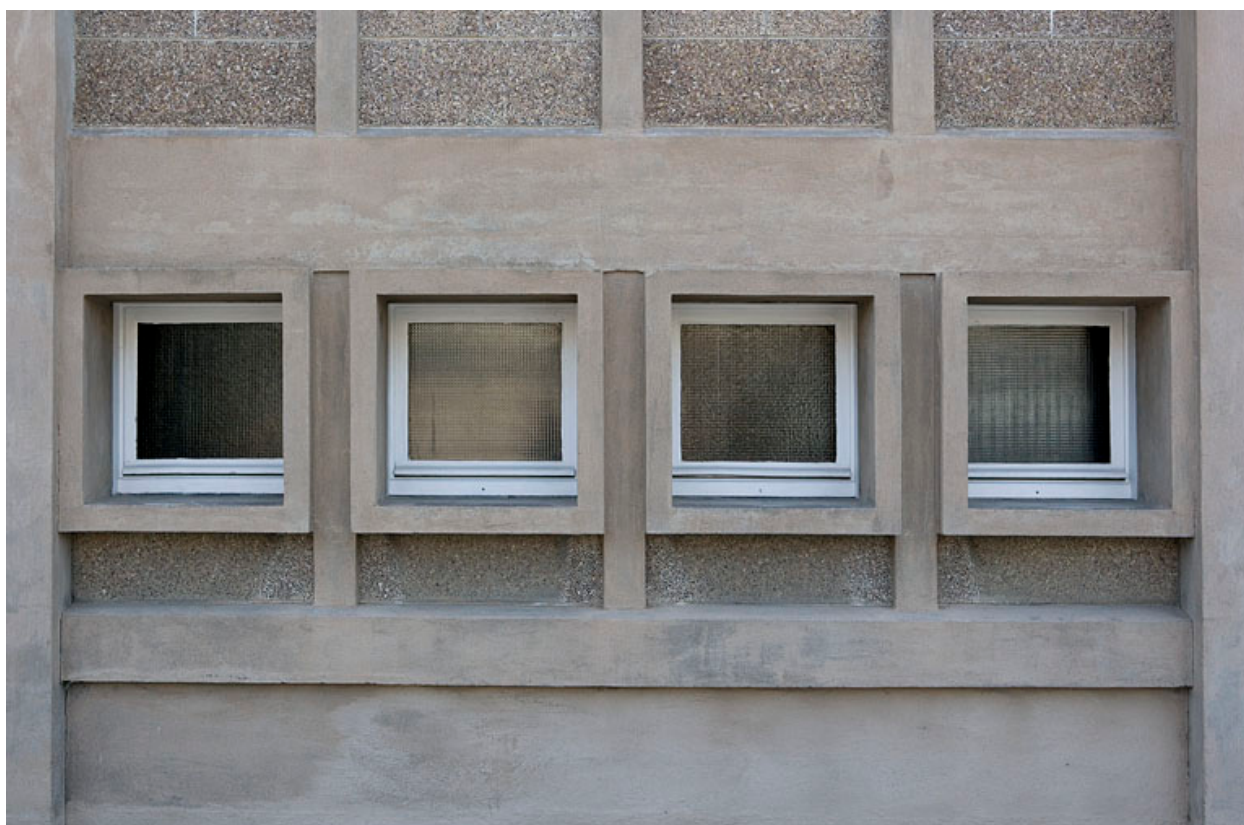
Face latérale droite : fenêtres carrées de la cage d'escalier.
