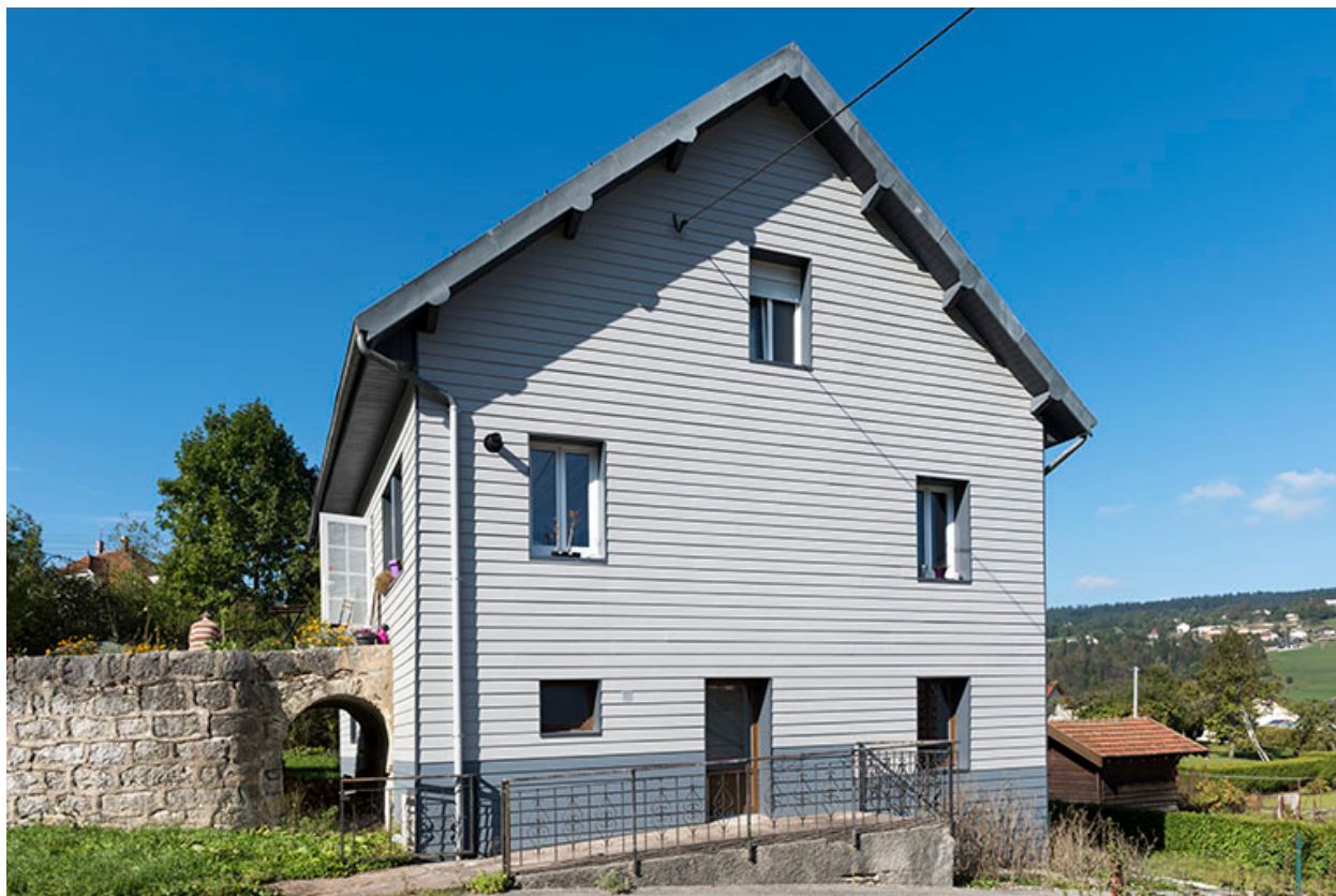
Façade latérale droite.
