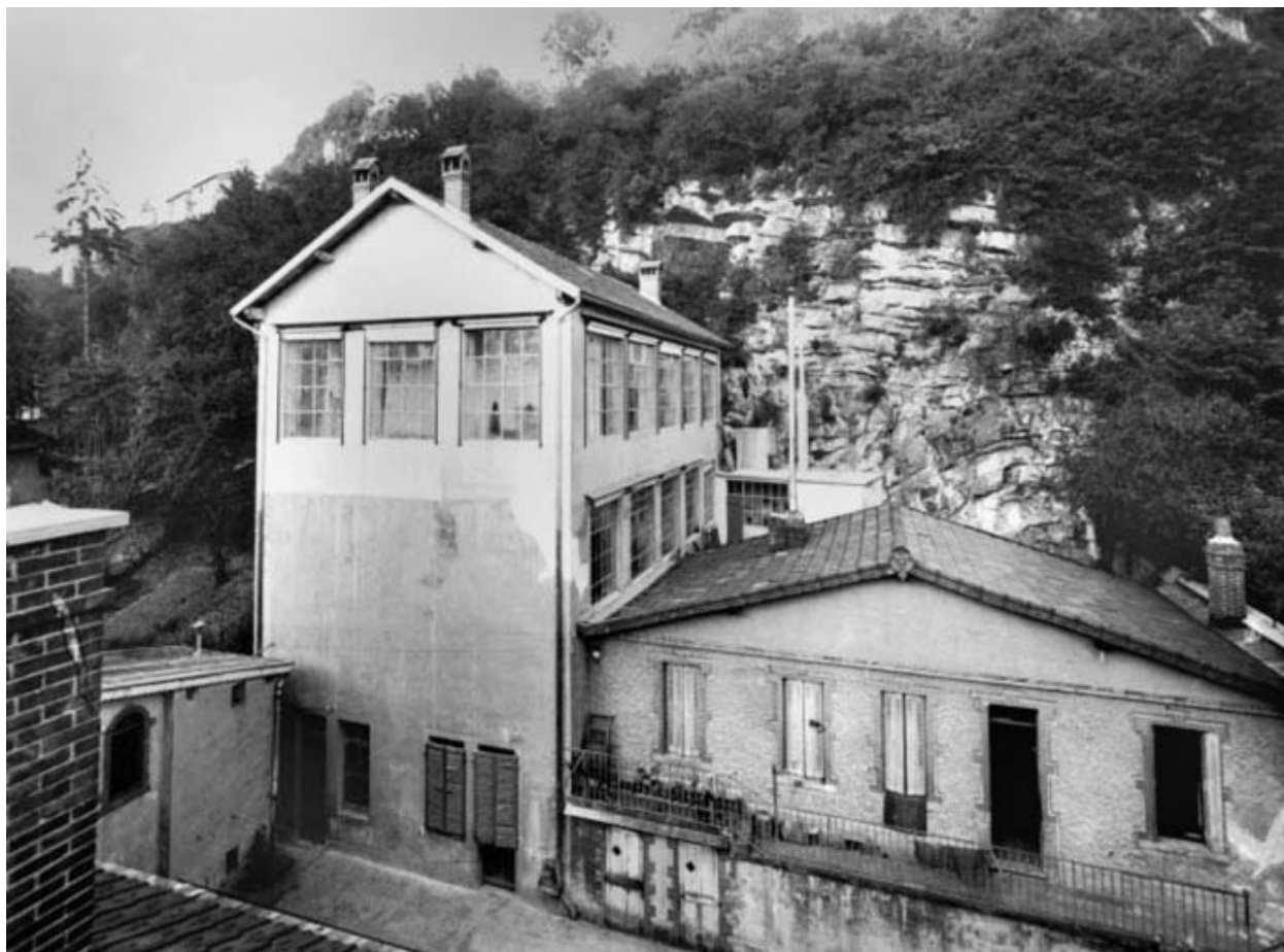
Façade antérieure, milieu 20e siècle.
