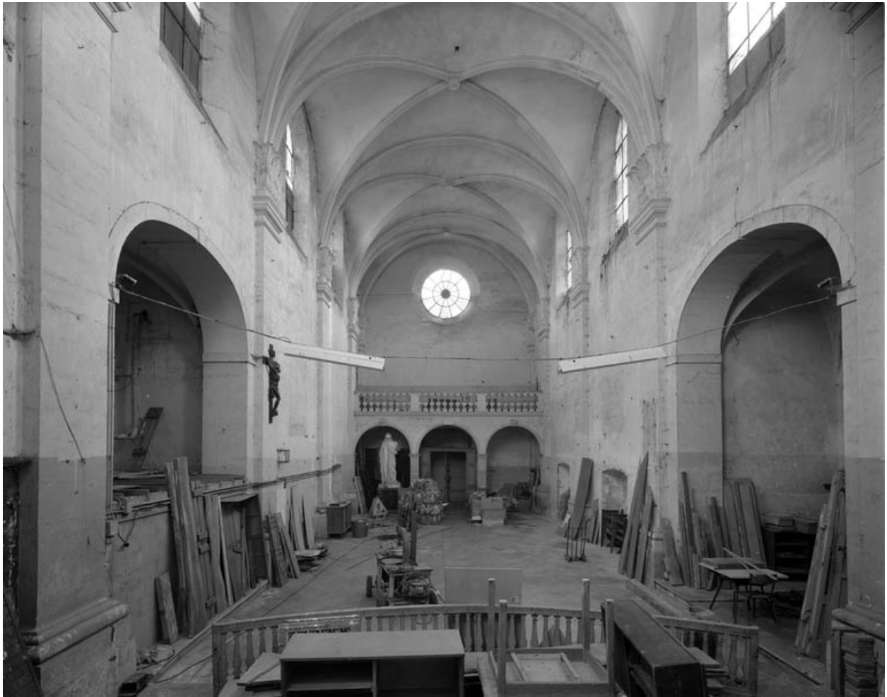
Chapelle : intérieur, nef depuis le choeur avec chapelles latérales en 1989.
