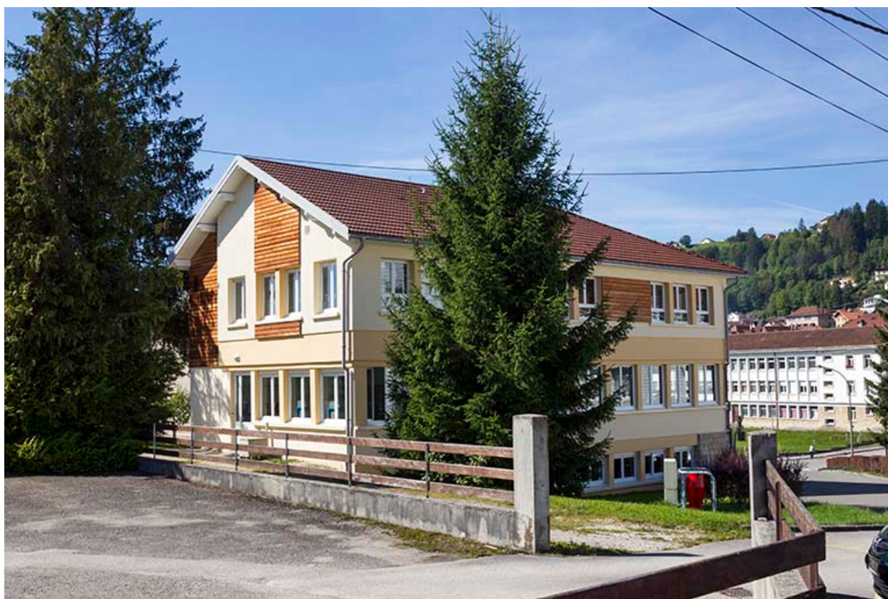
Façades postérieure et latérale gauche.
