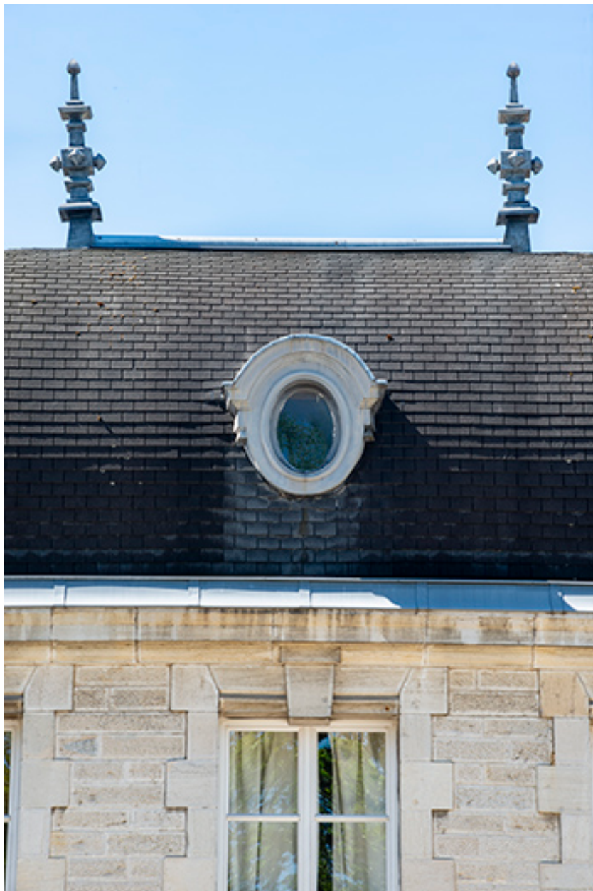
Façade principale, pavillon occidental, détail.
