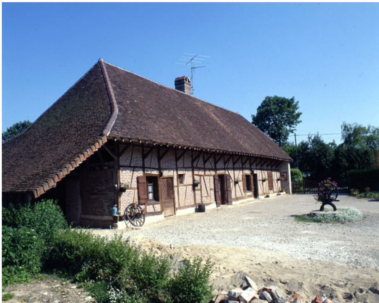
Bâtiment d'habitation : façade antérieure et cour en 1990.
