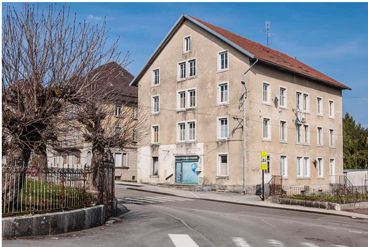
Façades antérieure et latérale droite.
