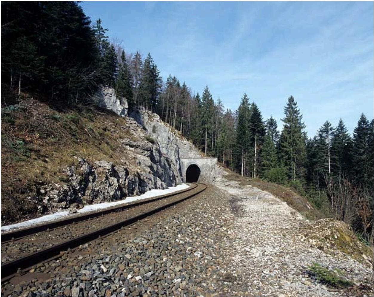
Vue d'ensemble de la tête côté La Cluse.
