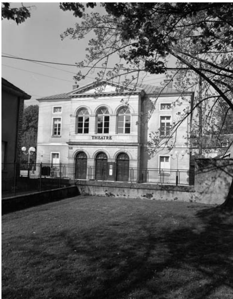
Façade antérieure depuis le parc de la Maison des Associations Grayloises.
