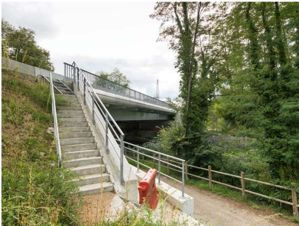
Vue d'ensemble du pont.
