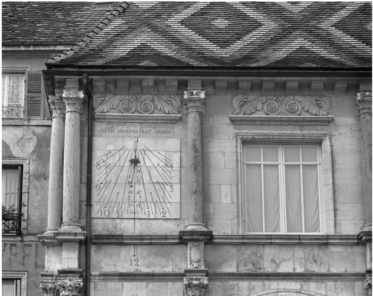
Façade antérieure : détail de la travée gauche du premier étage.
