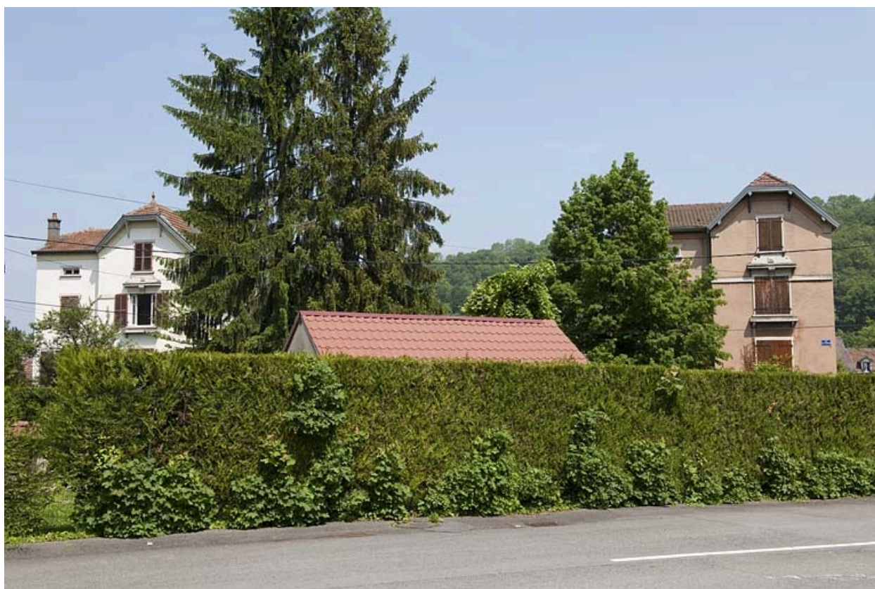
Vue d'ensemble depuis le sud.
