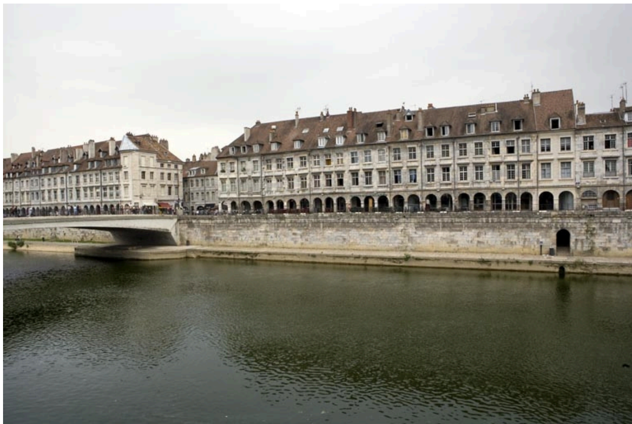
Besançon : pont Battant, quai Vauban et chemin de halage, depuis la rive droite en aval.
