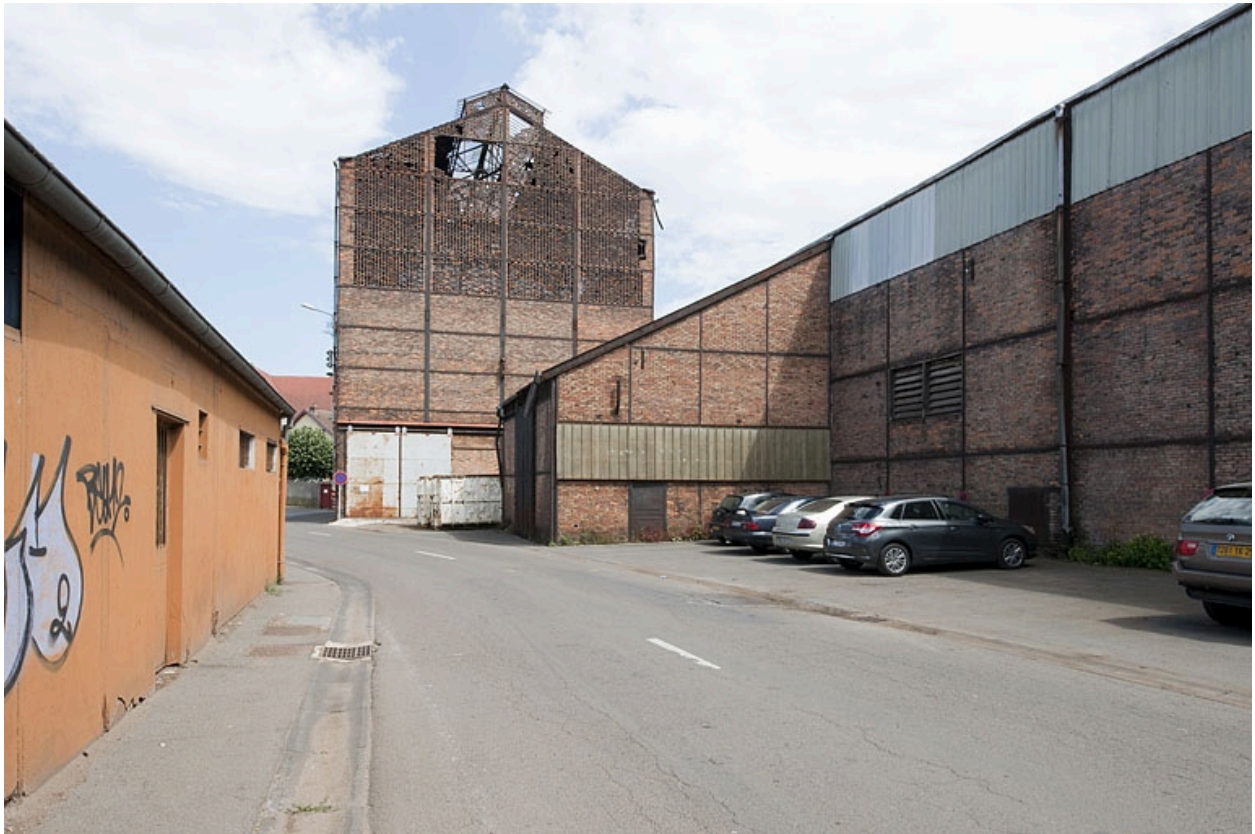
Bâtiment du gazogène et atelier de laminage depuis l'ouest.
