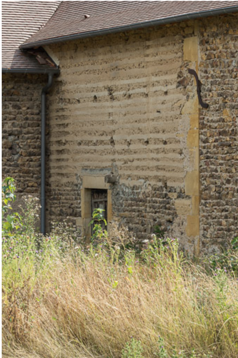
Détail d'un mur de la grange, partiellement bâti en pisé
