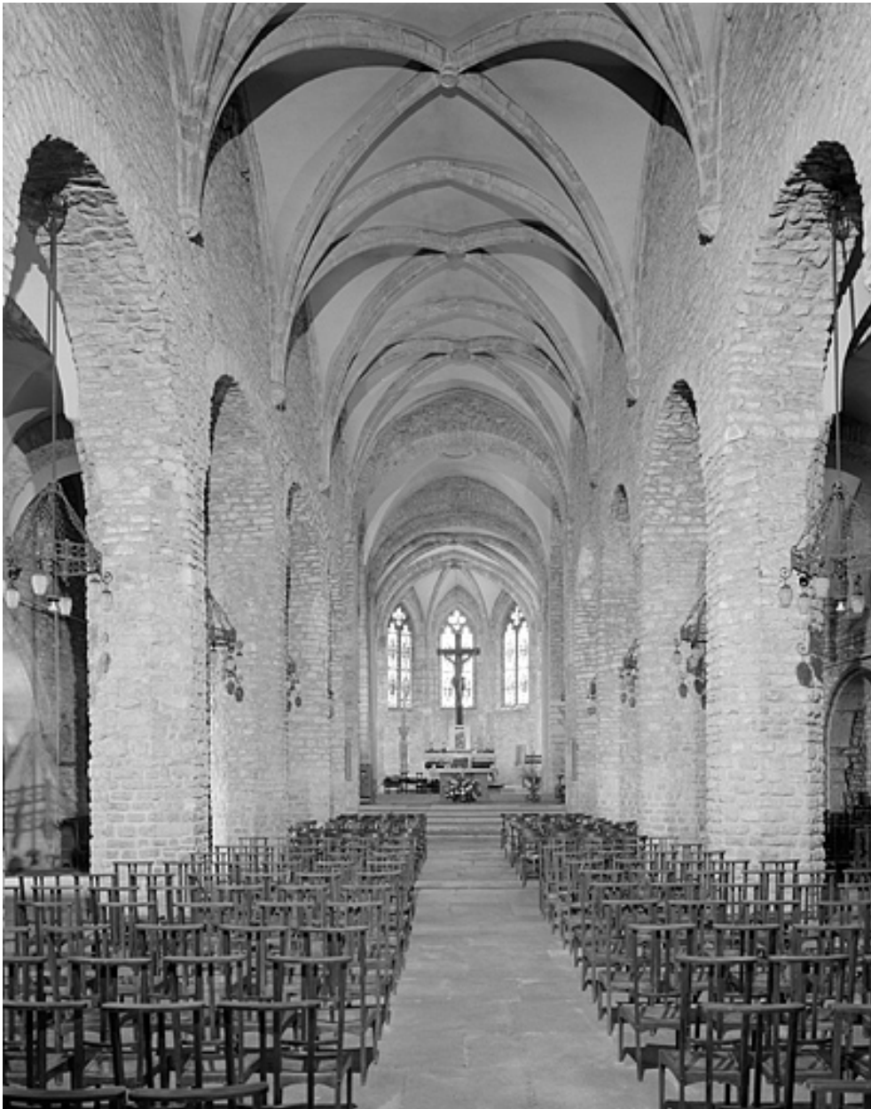
Eglise Saint-Désiré. Vaisseau central vu depuis l'ouest.
