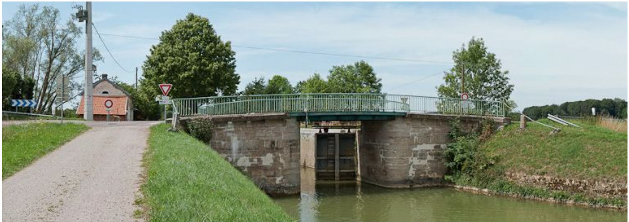
Vue du pont depuis l'aval.
