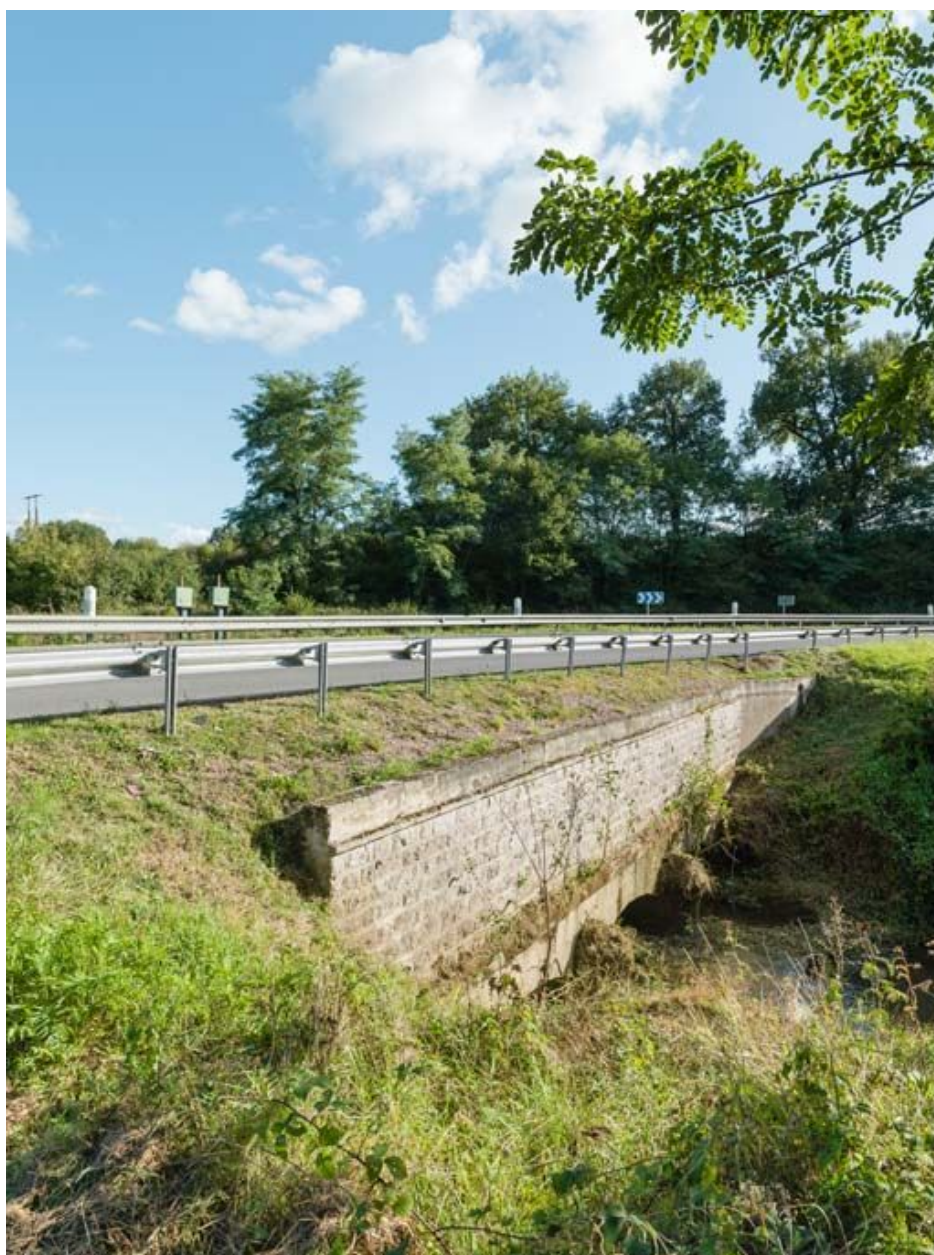
Vue de l'aqueduc.
