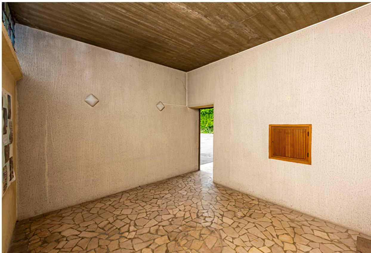
Chapelle des fonts baptismaux. Vue en direction de l'entrée.
