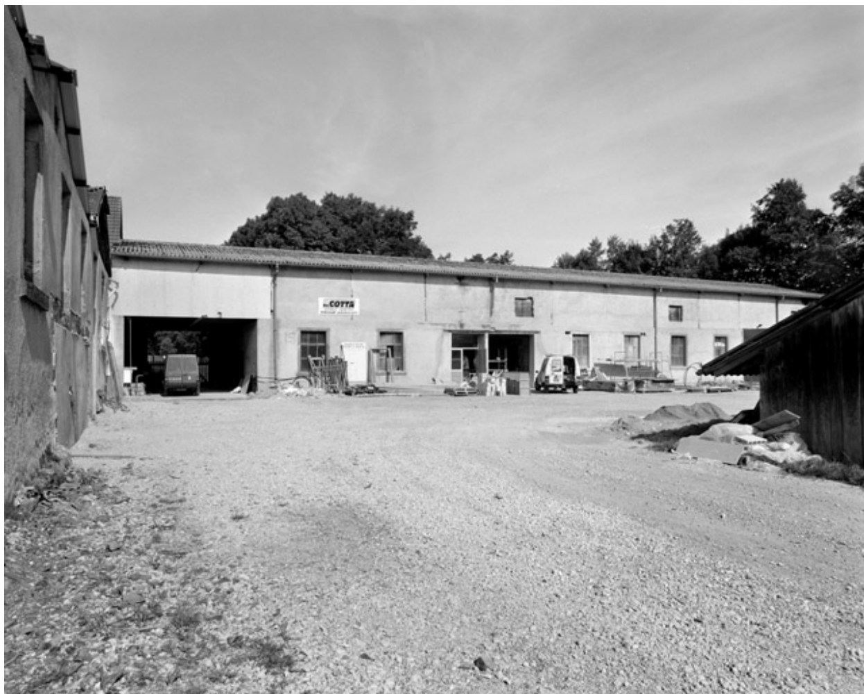
Atelier de fabrication ouest.
