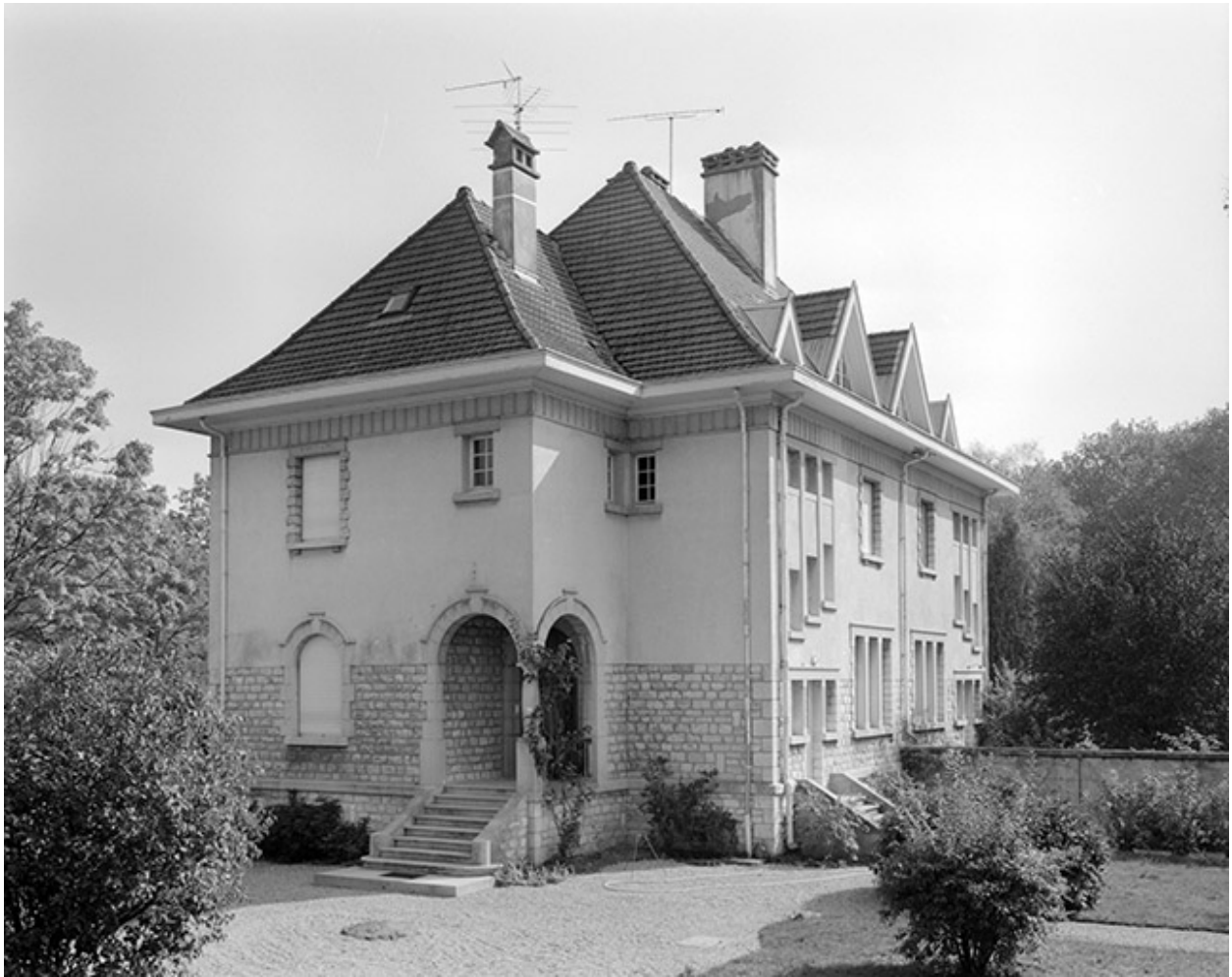
Façade postérieure et face droite.
